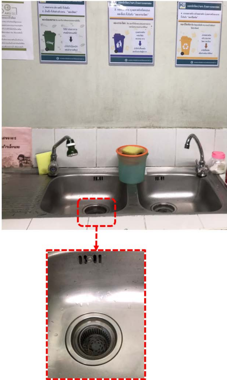
ภาพที่ 4.2.2-1 (1) การติดตั้งตะแกรงกรองเศษอาหารในอ่างล้างจาน
